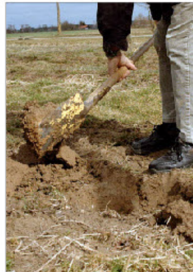
Ausgraben: Die Erde kommt auf zwei Haufen. Einer ist für die obere Schicht, der andere für die untere.
