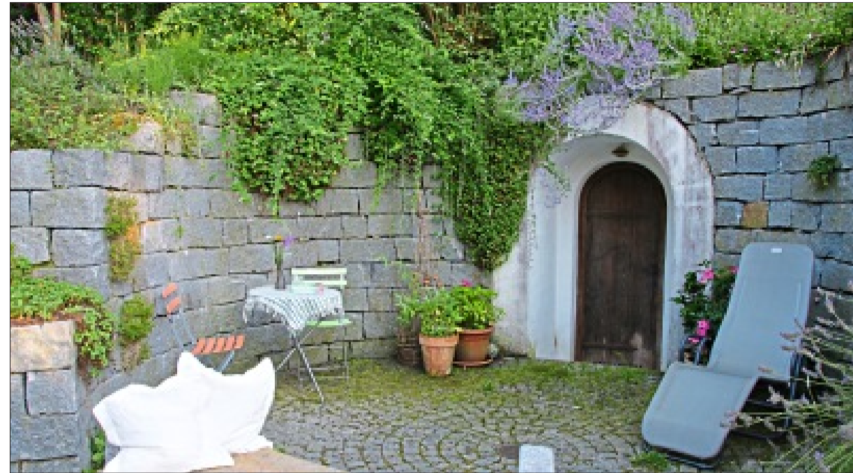
Der Erdkeller hält Obst und Gemüse frisch und Getränke kalt. Er wurde in den Hang gegraben, die Natursteinmauer aus Granit stabilisiert das Gelände. – Fotos: Doris Kessler
